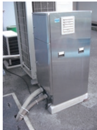
油脂分解処理装置
