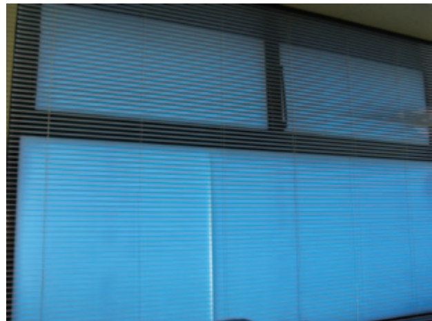
断熱ボードを取り付けた窓 (撮影の為ブラインドの羽根を開けています)
