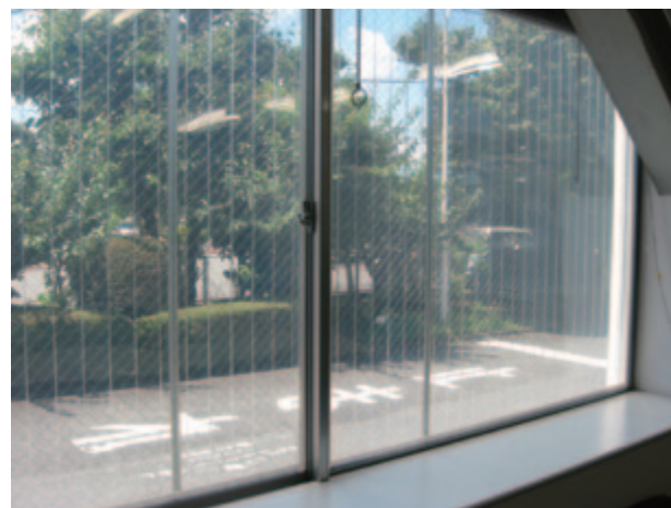
窓ガラスに貼付した断熱フィルム
