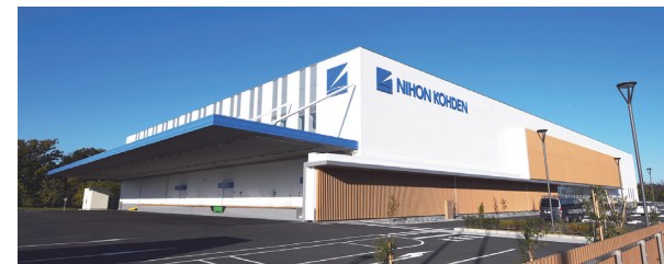
鶴ヶ島生産センタ外観
