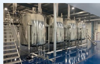
試薬製造タンク
